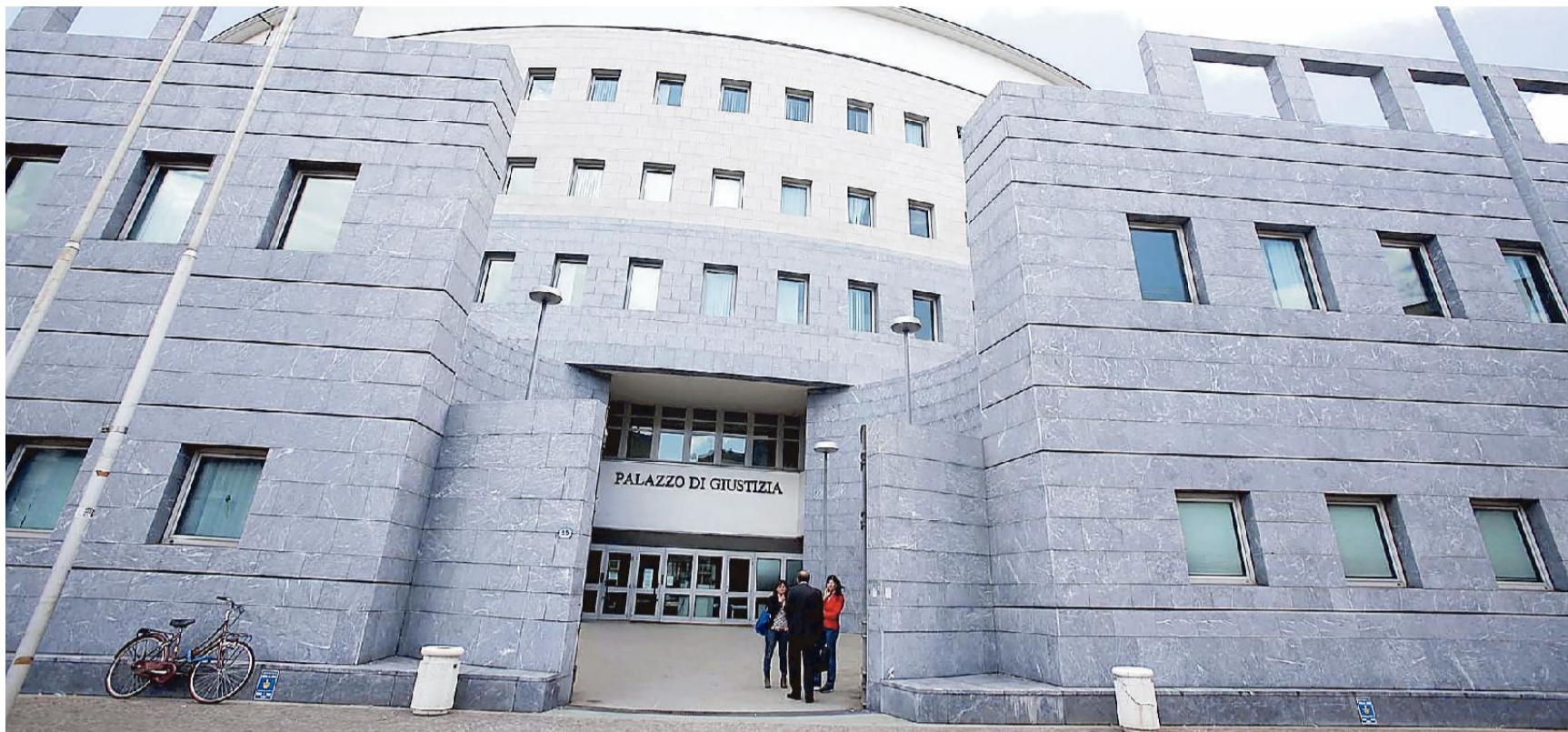
Il Palazzo di giustizia di Padova in via Tommaseo: dal 15 giugno riprendono i processi in aula sia nel penale che nel civile con una serie di misure di sicurezza
